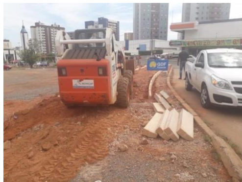
FOTO 32: CONSTRUÇÃO DE ESTACIONAMENTO
